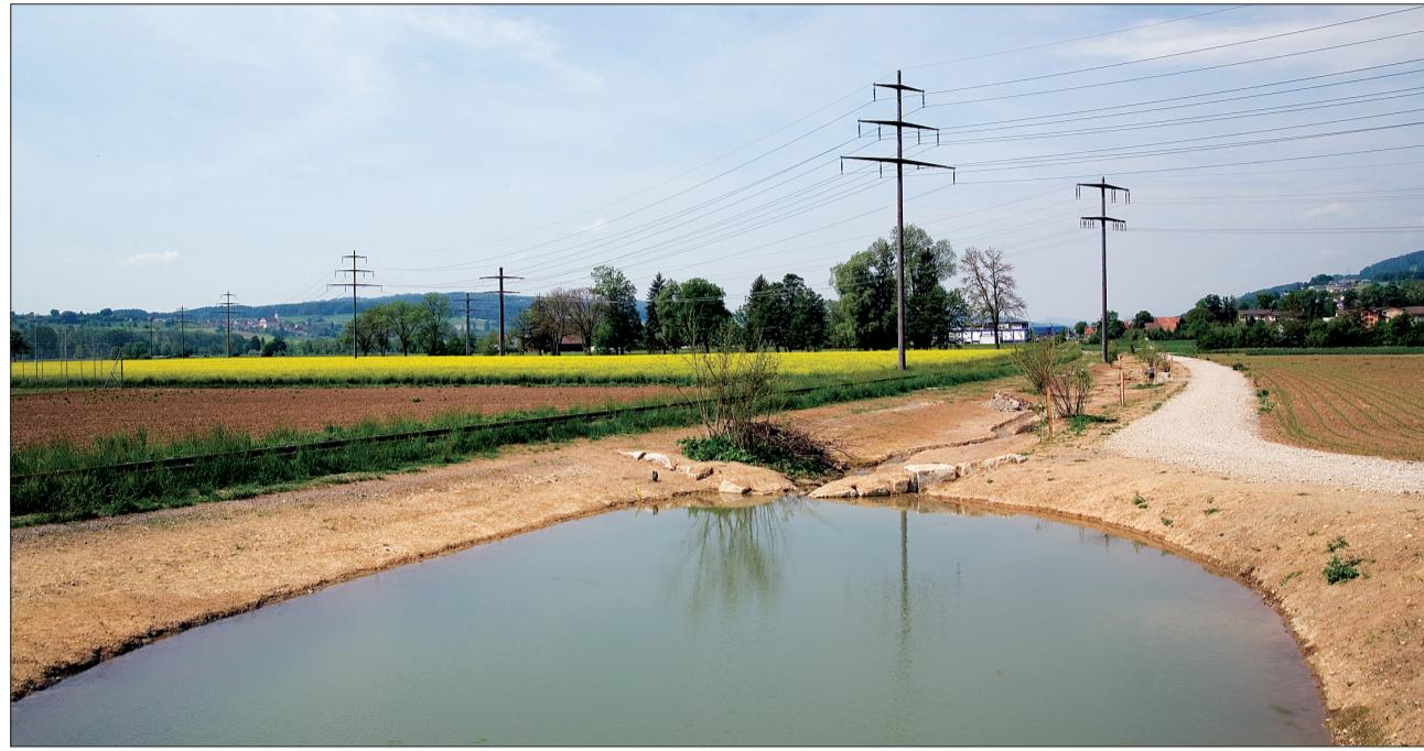
Der bei der Zollbachumlegung entstandene Weiher dient dem Hochwasserschutz. Neu fliesst der Zollbach entlang der Geleise. FOTO FZ
