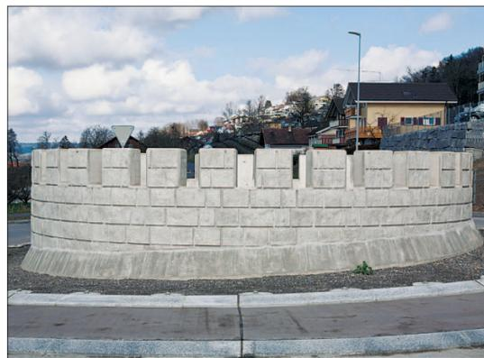
Die Verwendung einer Betonstrukturmatrize ermöglichte die kostengünstige Imitation einer Burgmauer.
